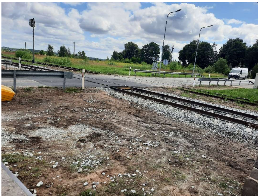
Geležinkelio kelias projektuojamo pėsčiųjų-dviračių tako vietoje
